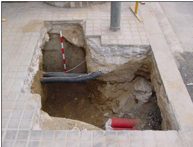
F3: Cala A. Encofrat UE 17, al fons, i UE 23, en primer terme. UUEE 9, 10, 11 i 27, en el tall, i UE 15, al fons.
