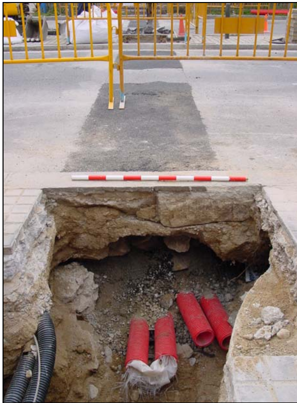
F5: Rases 1 i 2 recobertes amb grava i asfalt i amb els pericons instal·lats.
