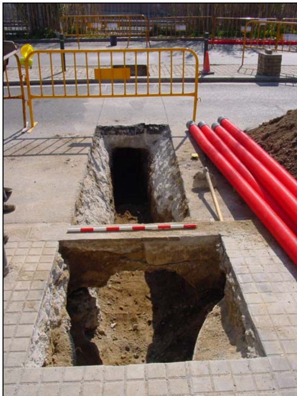
F1: Vista general de la cala A i la rasa 1, amb anterioritat a la col·locació dels pericons. En primer terme, a la dreta, estructura circular UE 23; en el centre, voraviu de la vorera (UE 27), i, al fons, UE 15.
