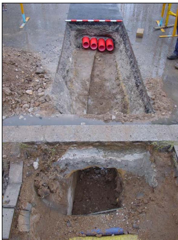
F4: Cala B i Rasa 2. En el centre voraviu UE 25 i UE 12. En el tall, les UUEE 19, 20 i 21; en el fons, la UE 22 i paret d'encofrat UE 17, pertanyents a la galeria i la UE 15.
